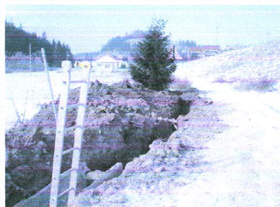
SO 03.2 Výtlačné potrubie V1 – pohľad na výkop pre potrubia DN 80
