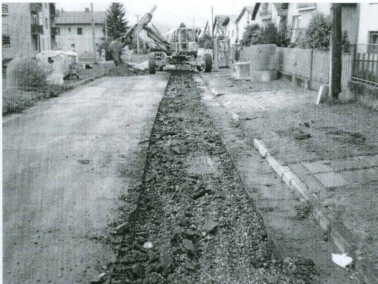
Fotografia č. 1 – SO Bobrovec – odstránenie krytu z vozovky
