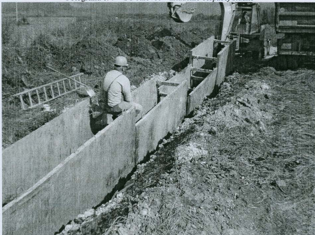
Fotografia č. 8 – SO Jalovec – výkop ryhy v pažení
