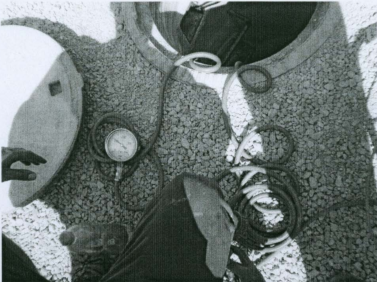
Fotografia č. 5 – SO Bobrovec – tlakové skúšky potrubia
