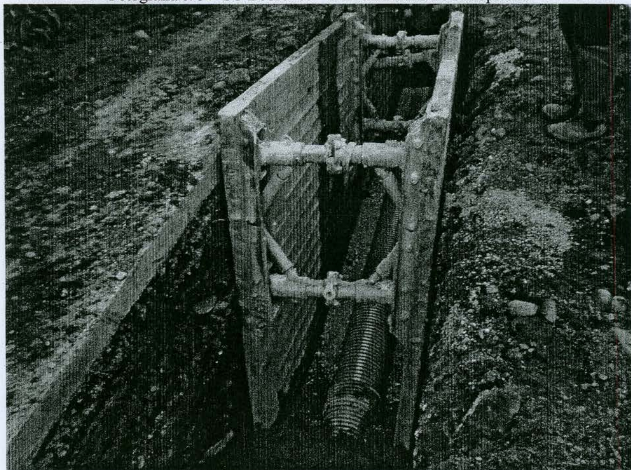
Fotografia č. 4 – SO Bobrovec – kontrola potrubia pred obsypom zo šrkopiesku
