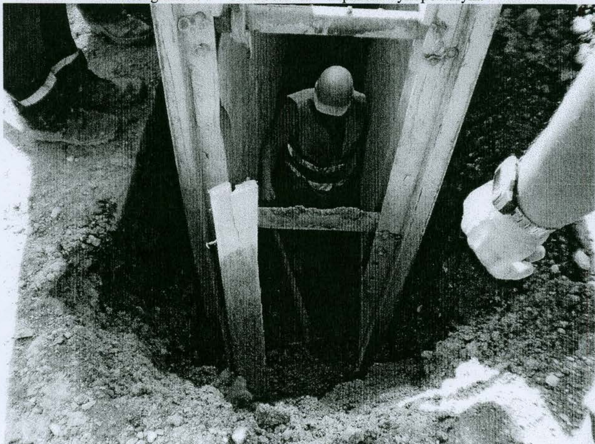
Fotografia č. 2 – SO Bobrovec – Realizovanie domovej prípojky
