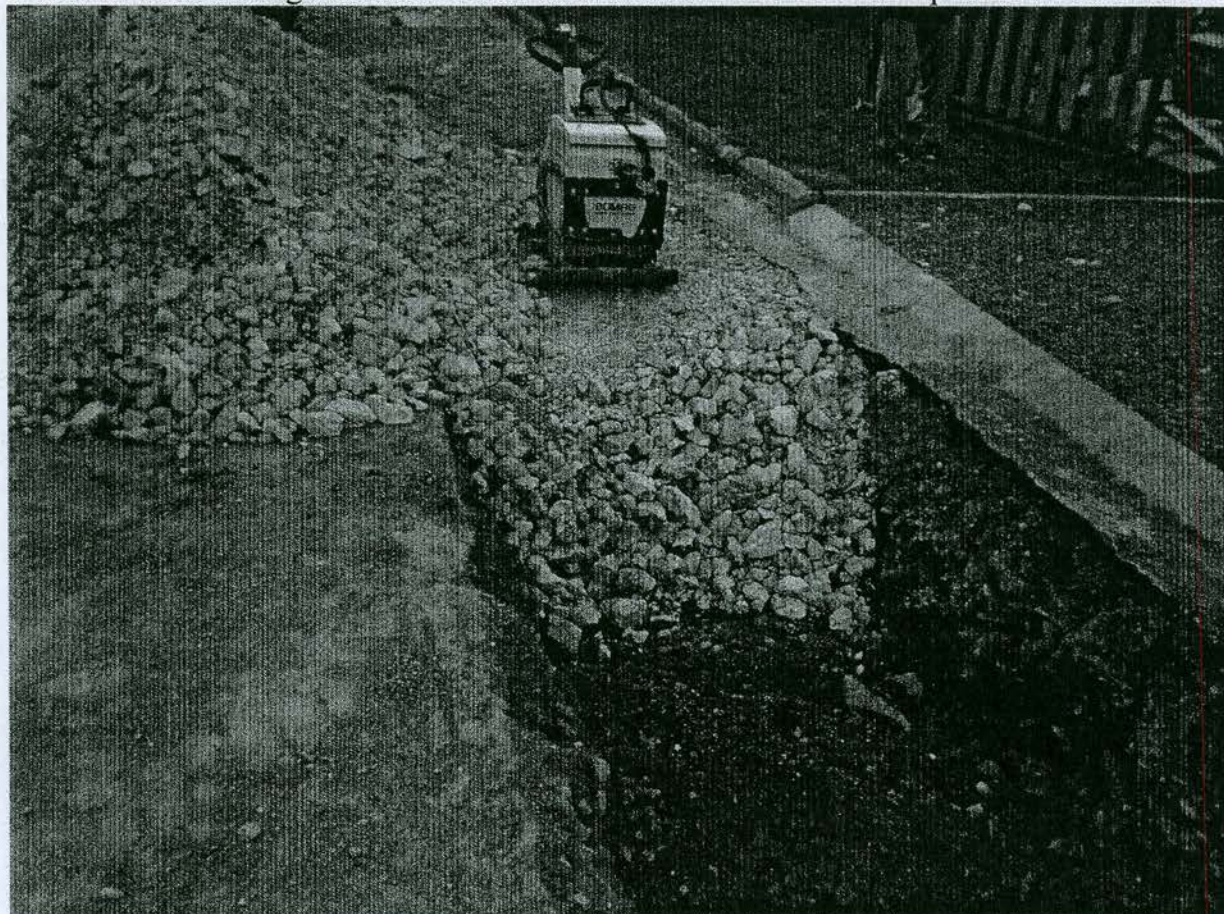
Fotografia č. 6 – SO Jalovec – dosypanie ryhy štrkodrvou fr.0-63mm zo zhutnením
