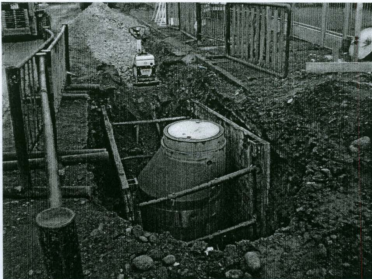
Fotografia č. 5 – SO Bobrovec – kanalizačná šachta v pažení
