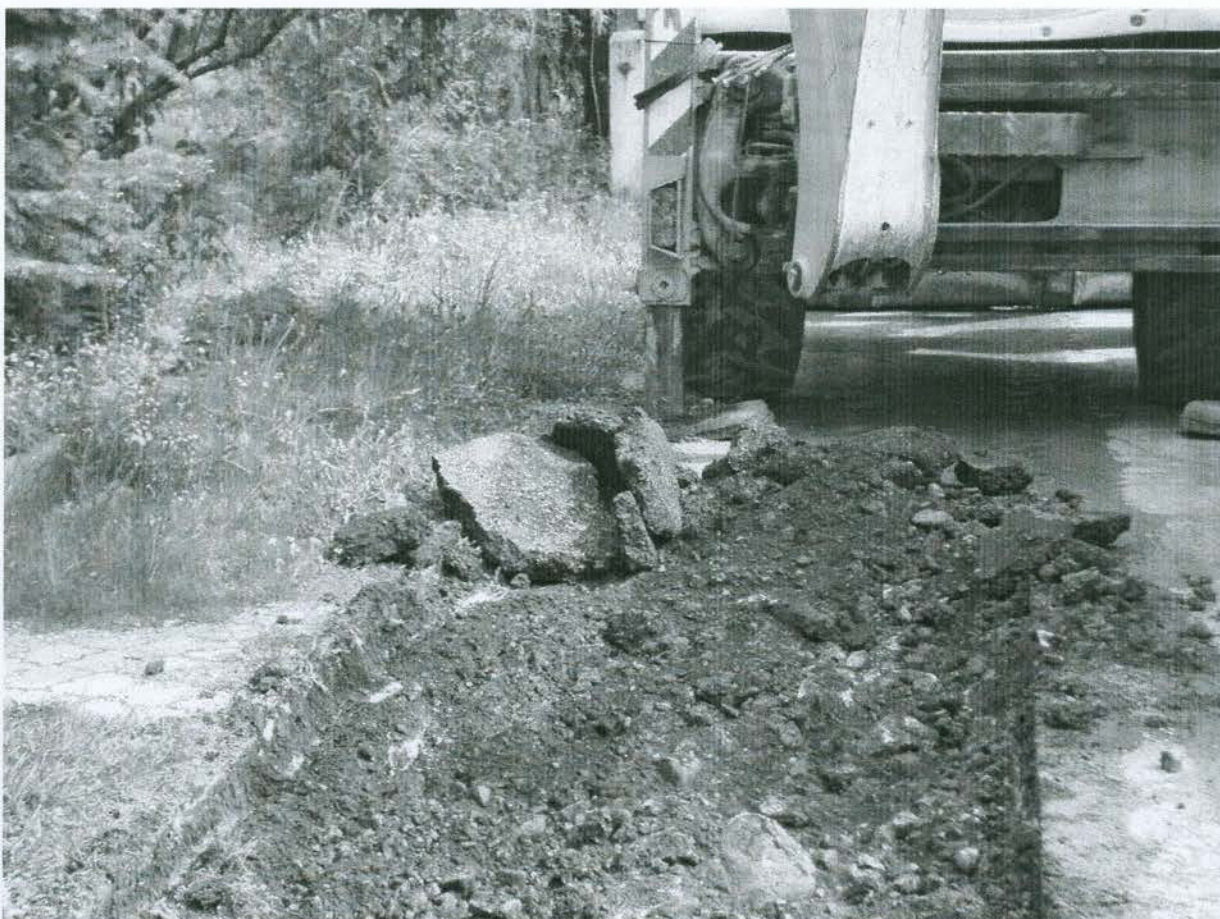
Fotografia č. 7 – SO Jalovec – odstránenie podkladu z vozovky
