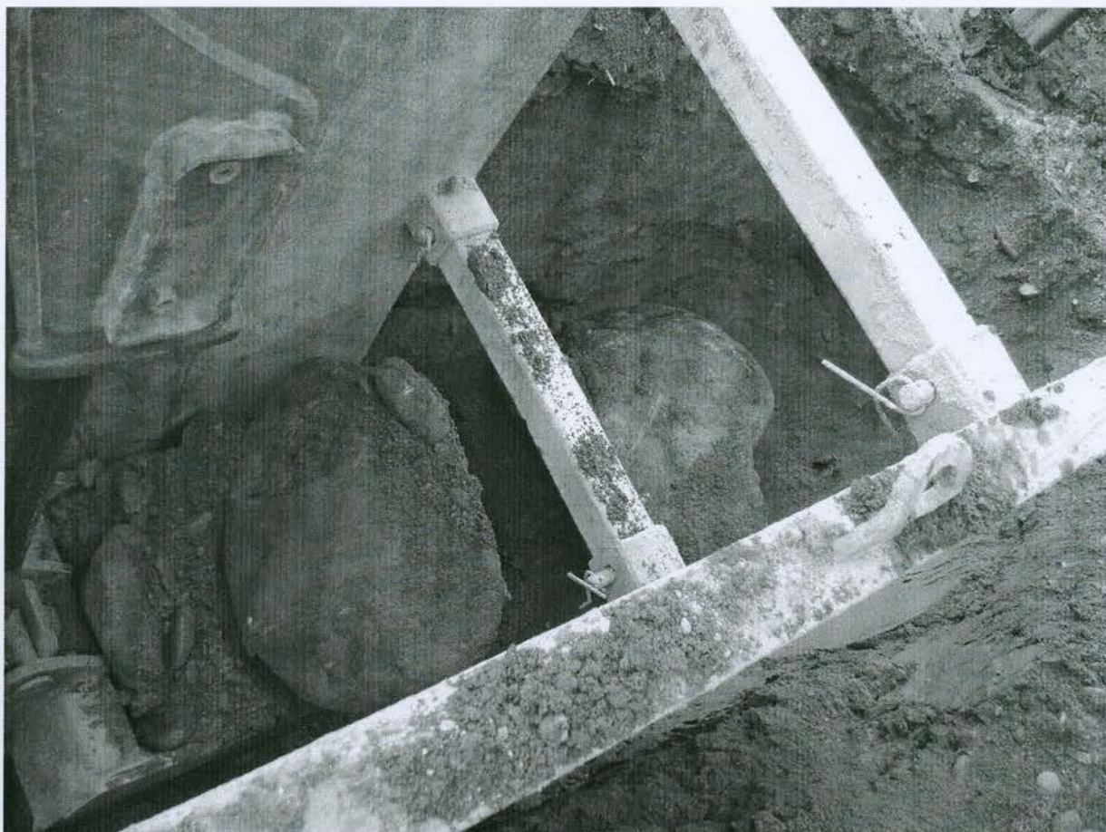
Fotografia č. 5 – SO Jalovec – sťažený výkop
