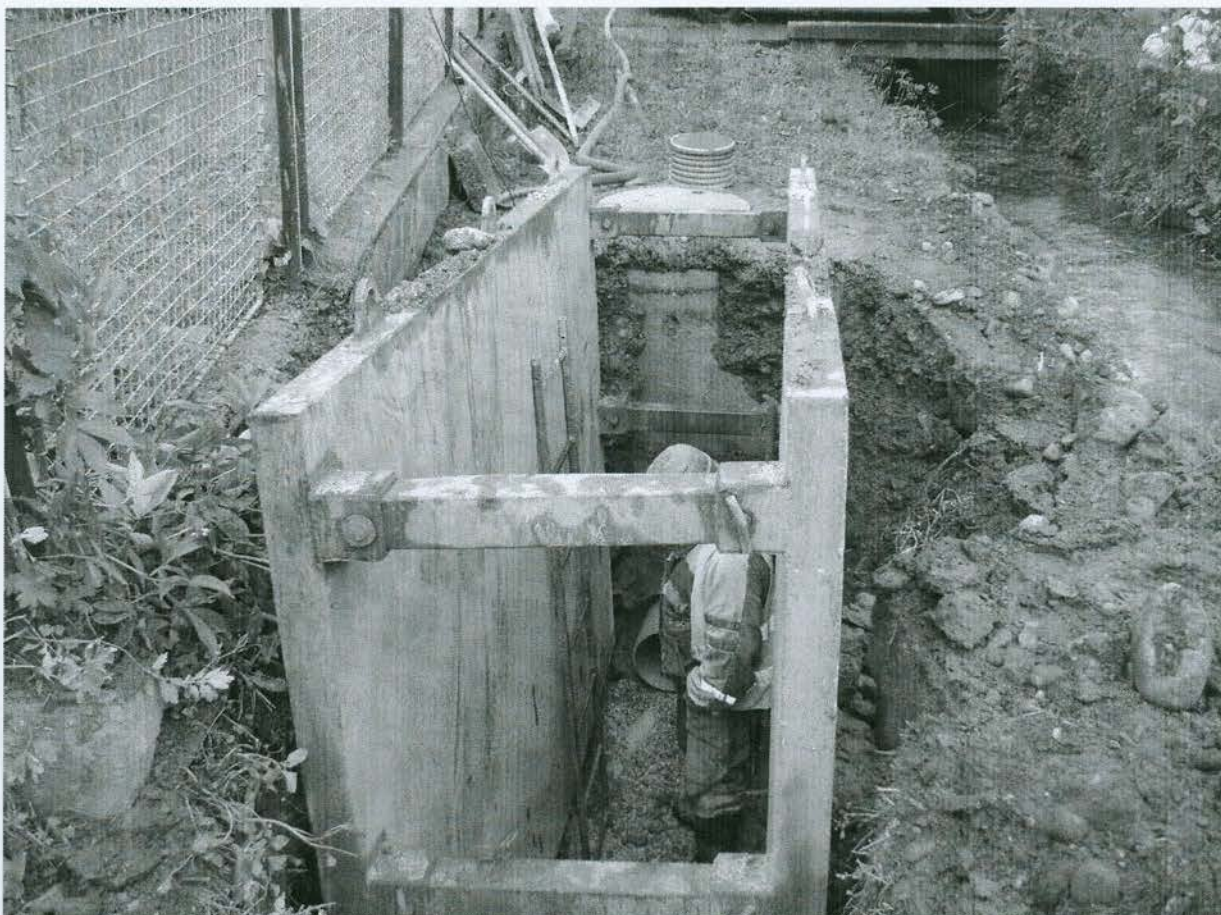
Fotografia č. 1 – SO Jalovec – príprava lôžka pod PVC potrubie
