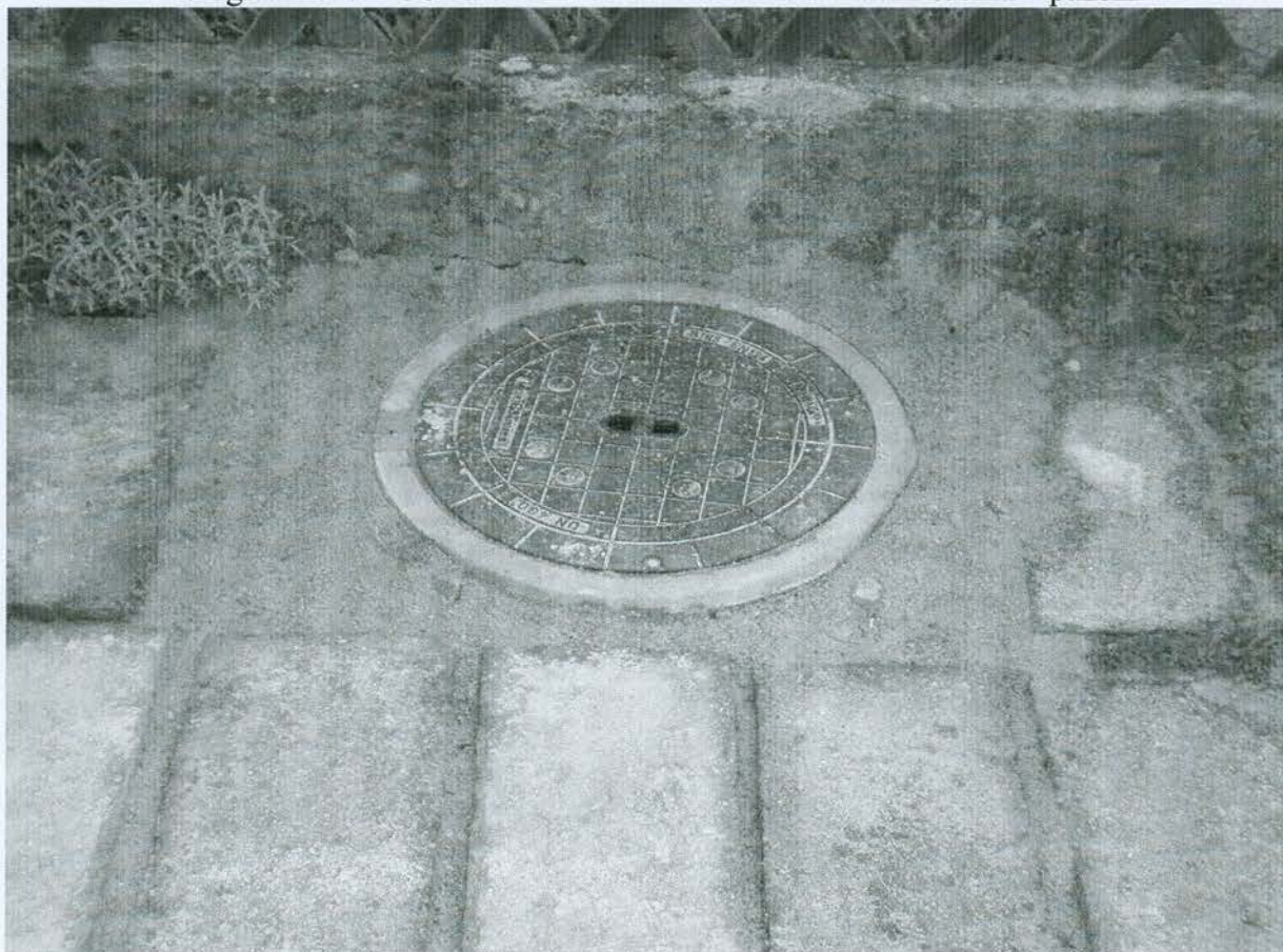
Fotografia č. 8 – SO Jalovec – osadenie poklopu na domovú RŠ
