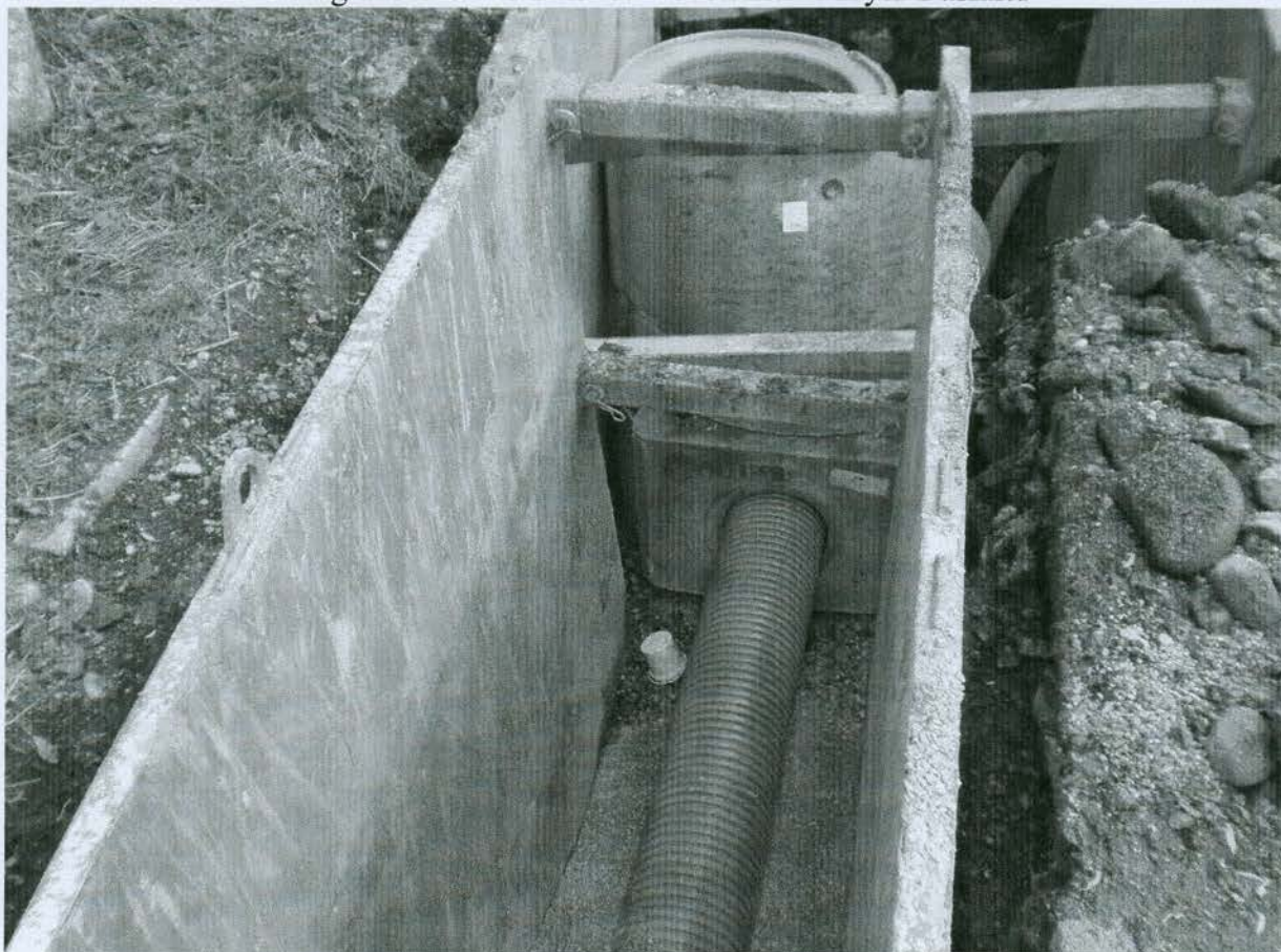
Fotografia č. 6 – dopojenie kanalizačného potrubia na kanalizačnú šachtu
