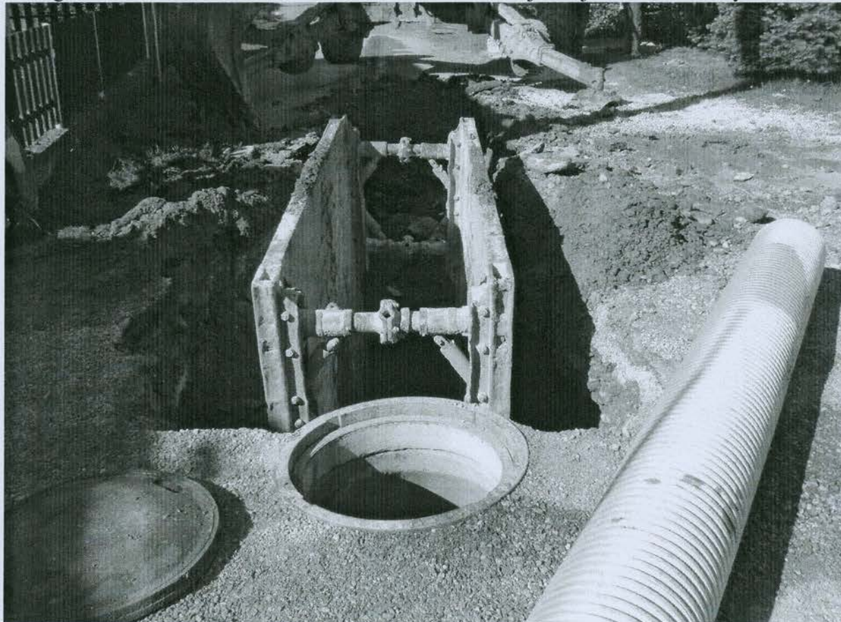
Fotografia č. 4 – SO Bobrovec – osadenie pažiacceho boxu
