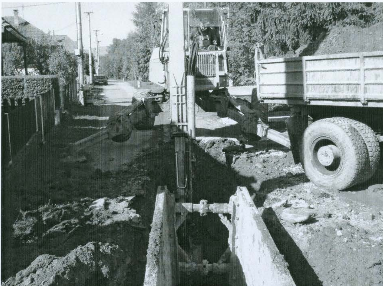
Fotografia č. 1 – SO Bobrovec – výkop ryhy v pažení
