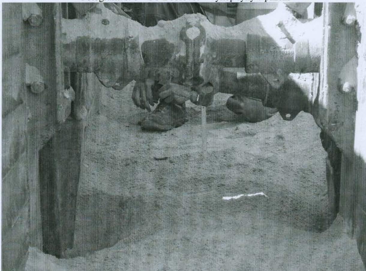
Fotografia č. 2 – SO Bobrovec – kontrola hrúbky obsypu kanalizačného potrubia
