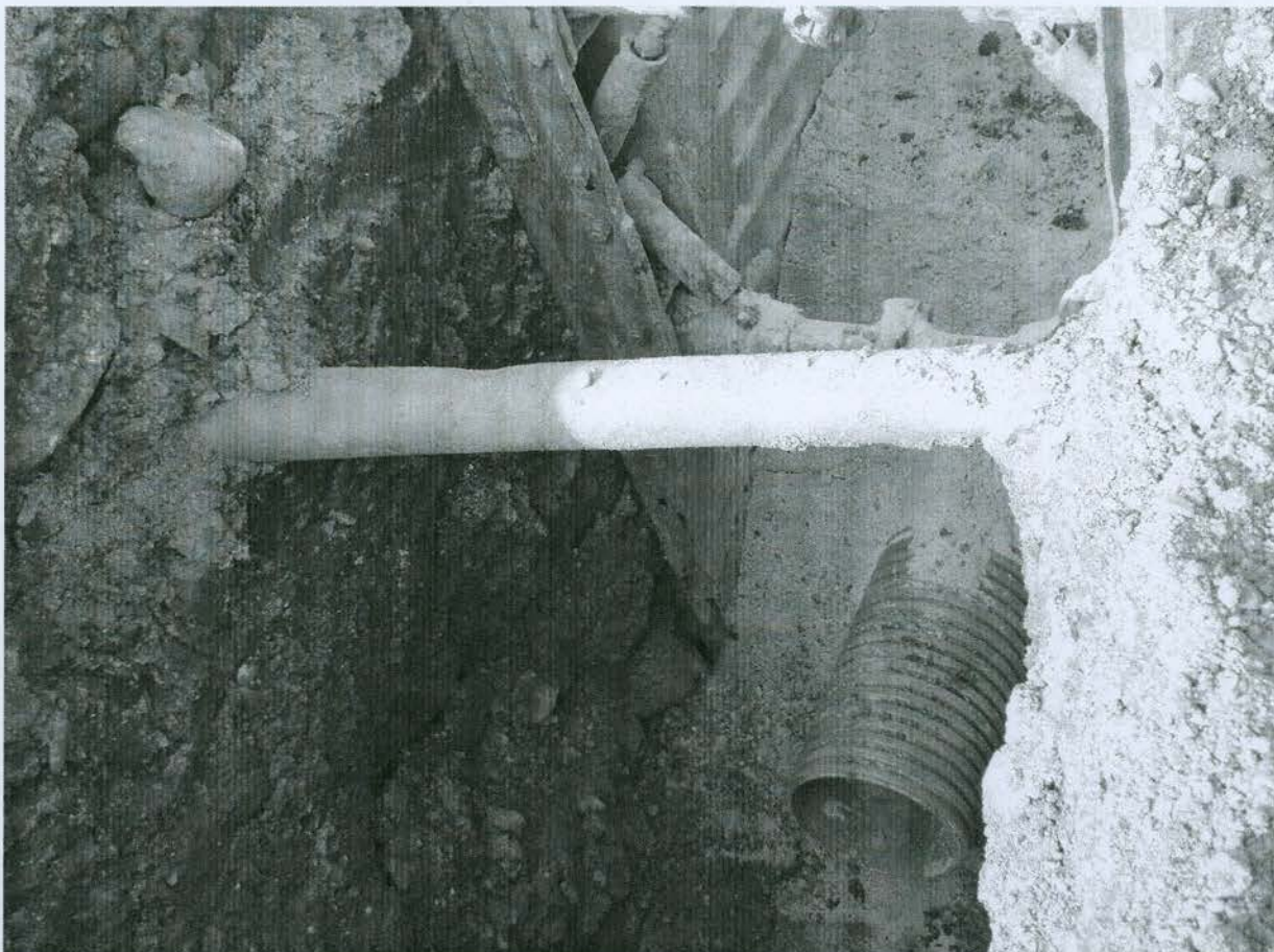
Fotografia č. 3 – SO Bobrovec – križovanie kanalizácie s existujúcimi inžinierskymi sieťami
