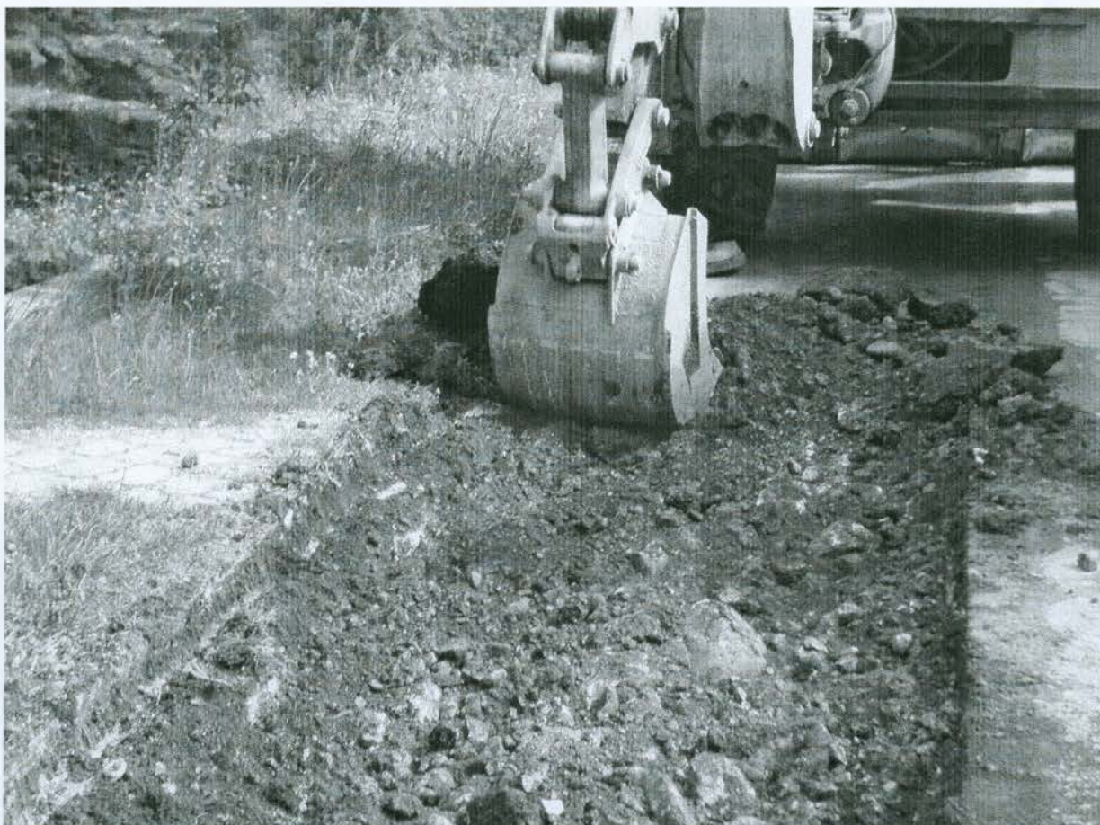
Fotografia č. 5 – O Jalovec – odstránenie krytu z asfaltu
