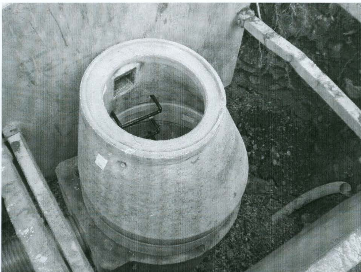
Fotografia č. 7 – SO Jalovec – zmontovaná kanalizačná šachta v pažení
