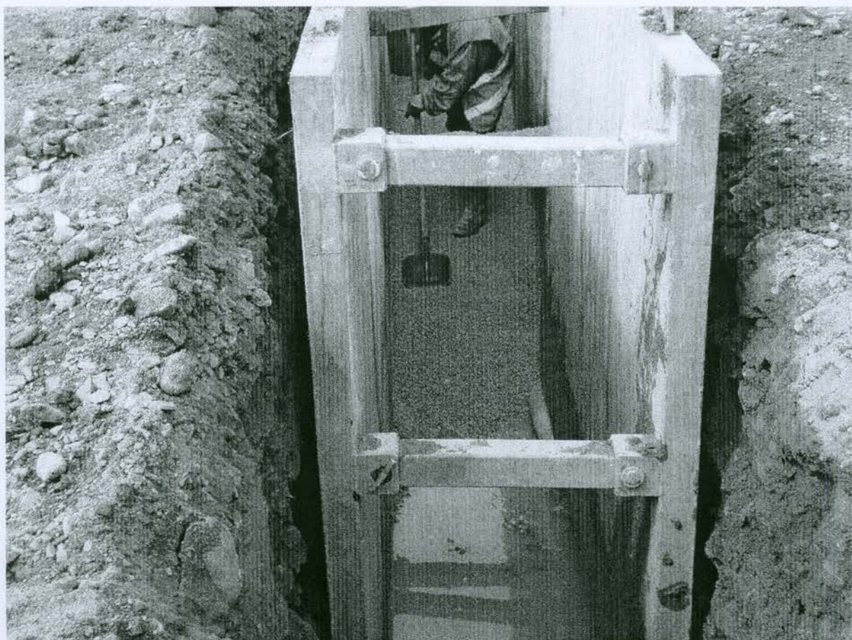
Fotografia č. 1 – SO Bobrovec – zriadenie lôžka pre výtlačné potrubie
