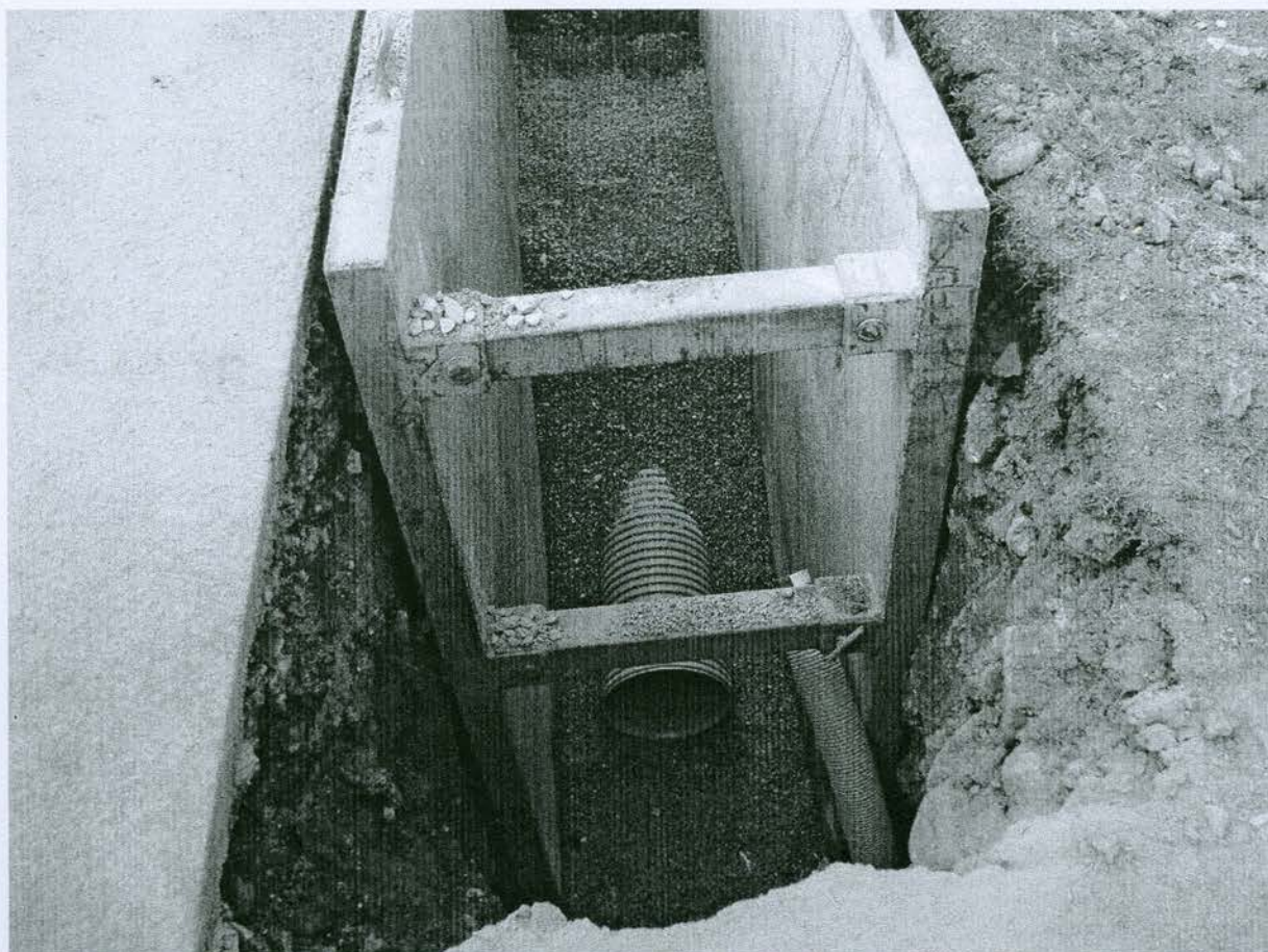
Fotografia č. 7 – SO Jalovec – budovanie kanalizačného zberača „JD“ s drenážou
