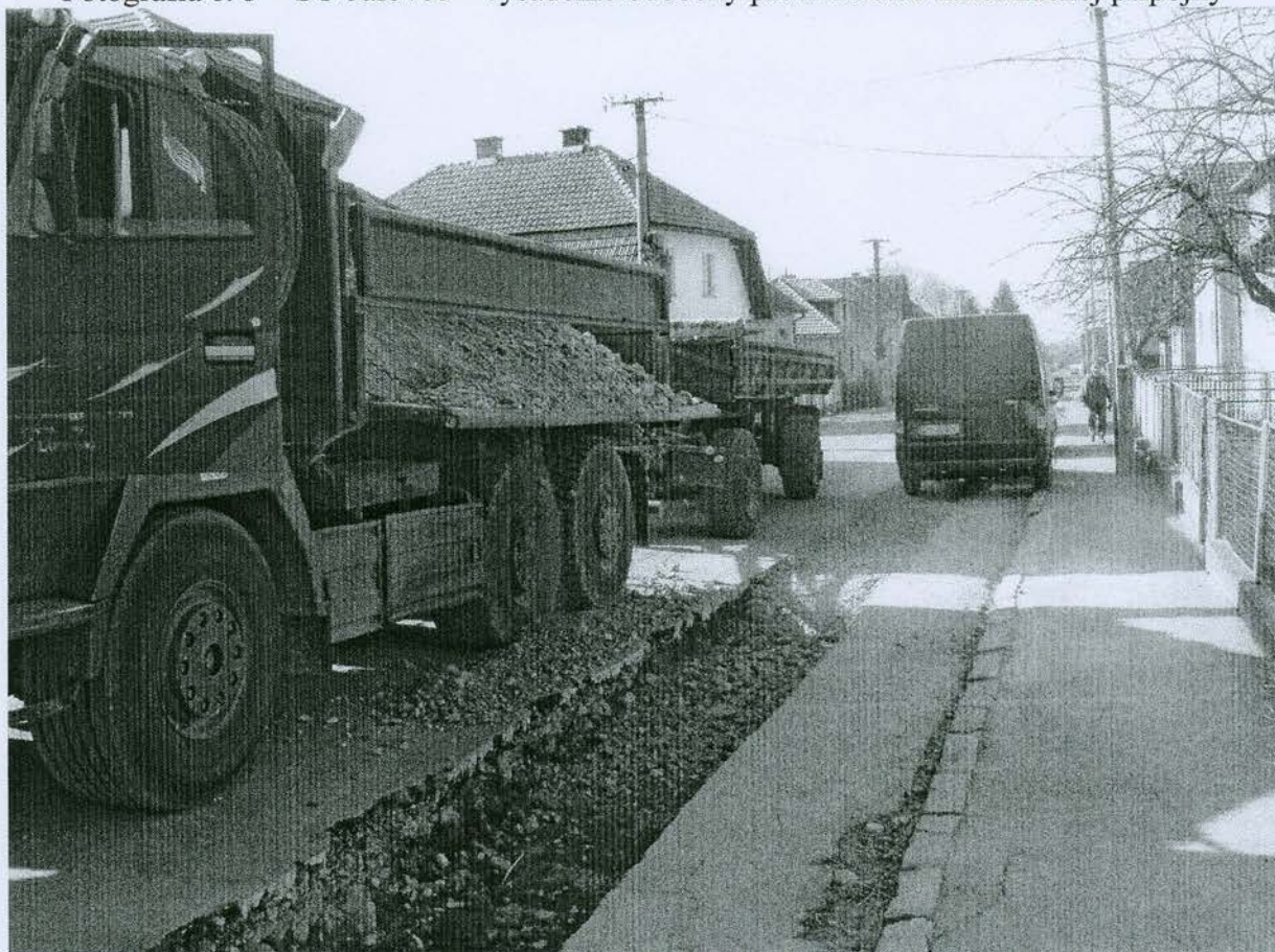
Fotografia č. 6 – dosypanie rýh kamenivom fr. 0-63 mm hrúbky 400 mm
