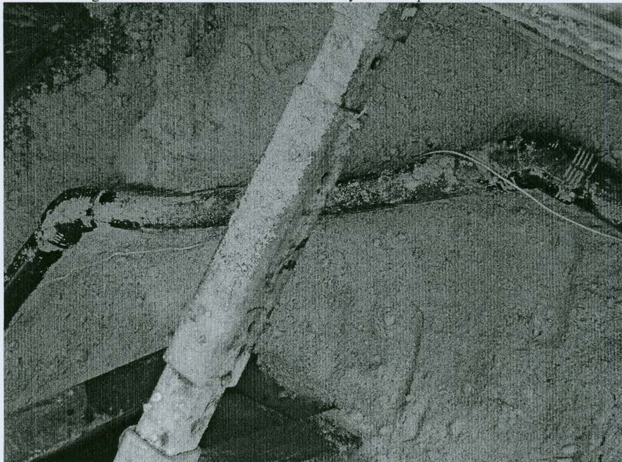
Fotografia č. 4 – SO Bobrovec – zozvárané výtlačné potrubie s vyhľadavacím vodičom
