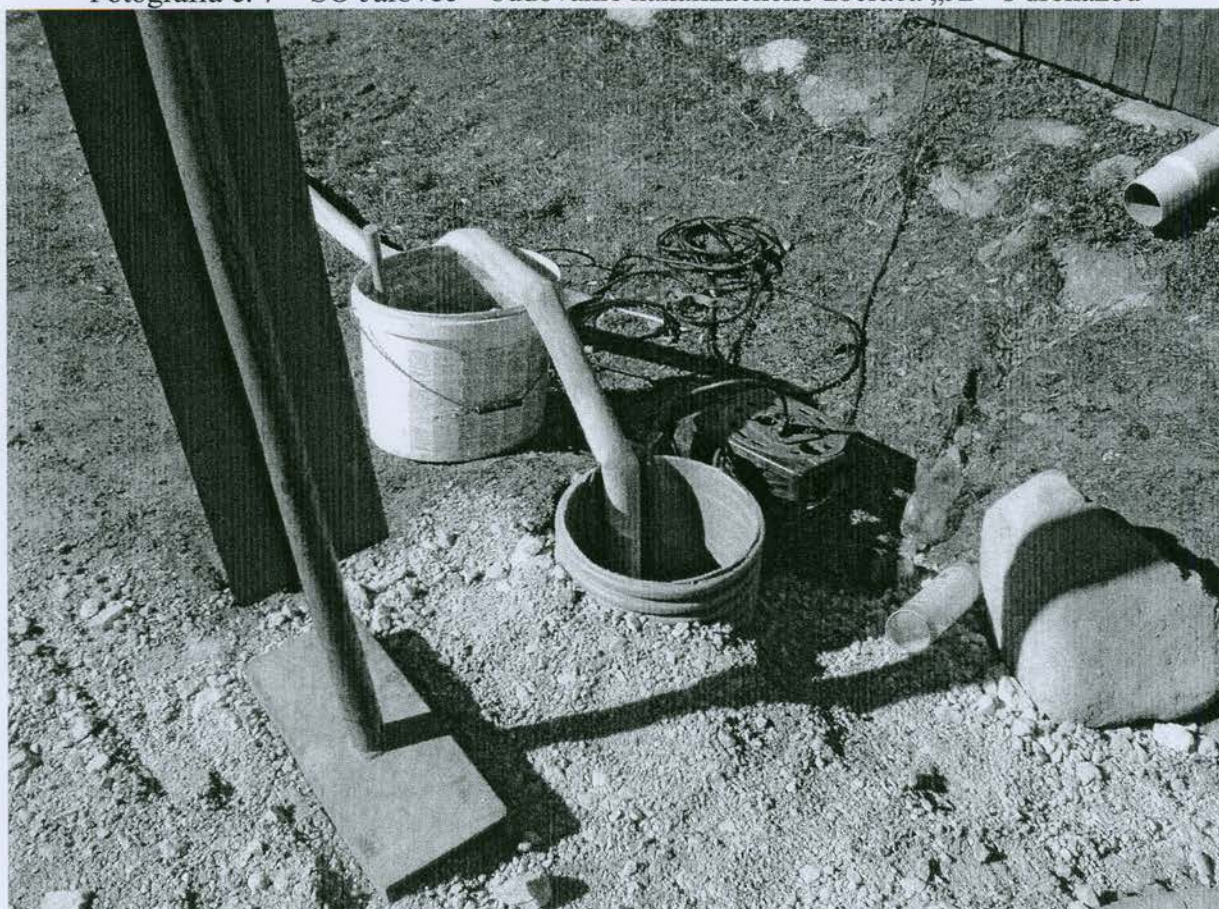
Fotografia č. 8 – SO Jalovec - čerpacia studňa na odčerpávanie spodnej vody z výkopu
