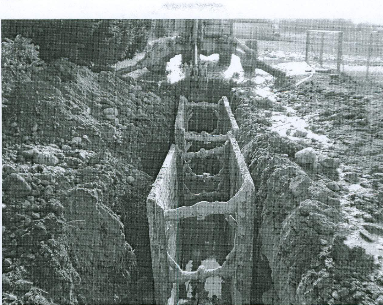
Fotografia č. 3 – hĺbenie rýh v pažení (pažiacie boxy)
