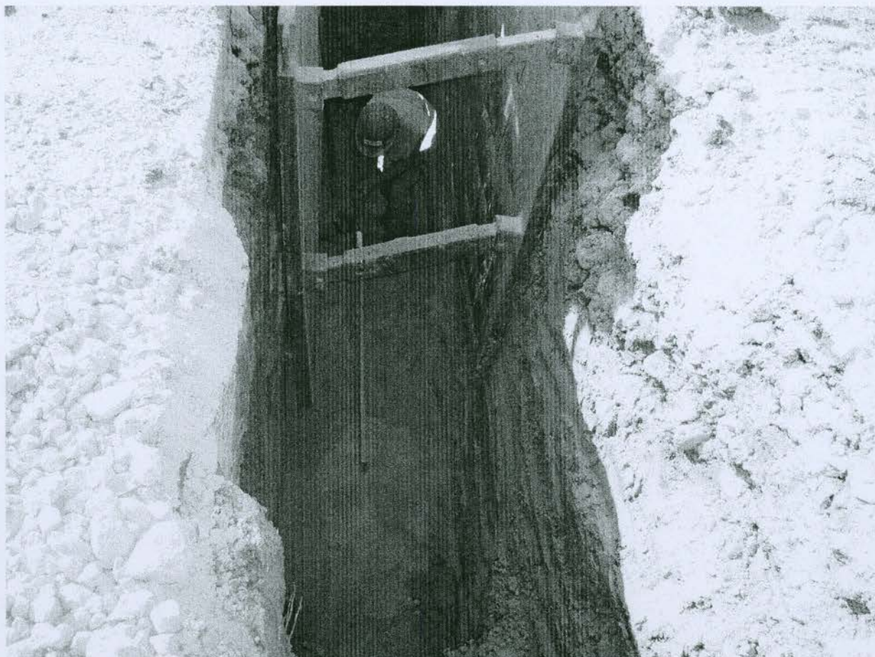
Fotografia č. 3 – SO L. Mikuláš Stošice – Príprava lôžka pod DN 300
