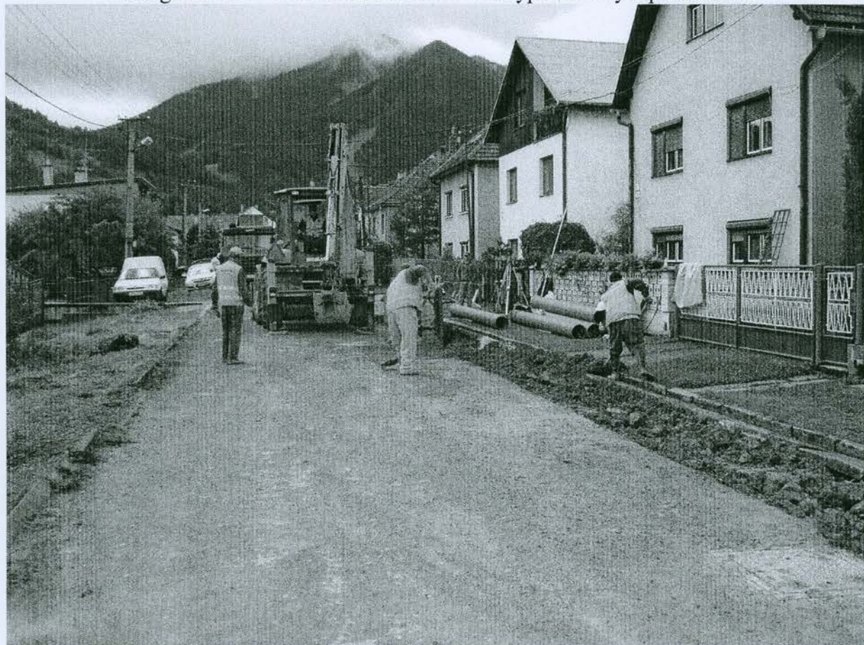
Fotografia č. 8 – SO Závažná Poruba – Zásyp ryhy, prehutnenie a dosypanie pre fr. 0/64
