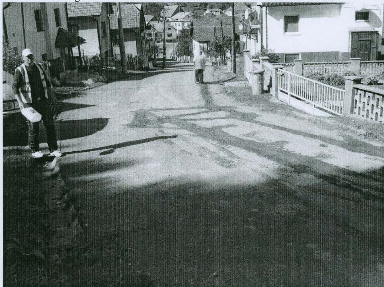
Fotografia č. 6 – SO Závažná Poruba – Príprava pre výkop
