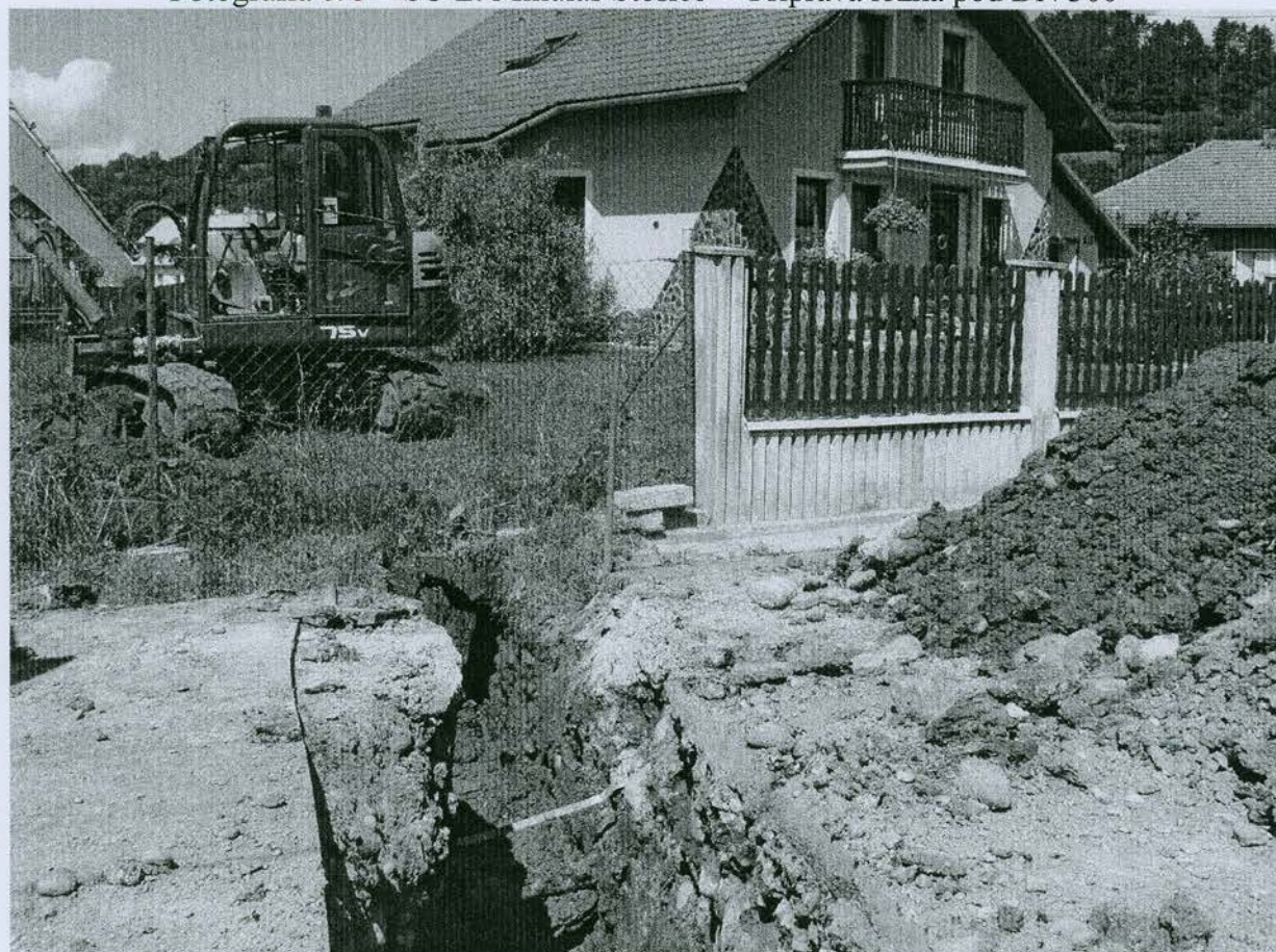
Fotografia č. 4 – SO L. Mikuláš Stošice – Výkop pre domovú prípojku
