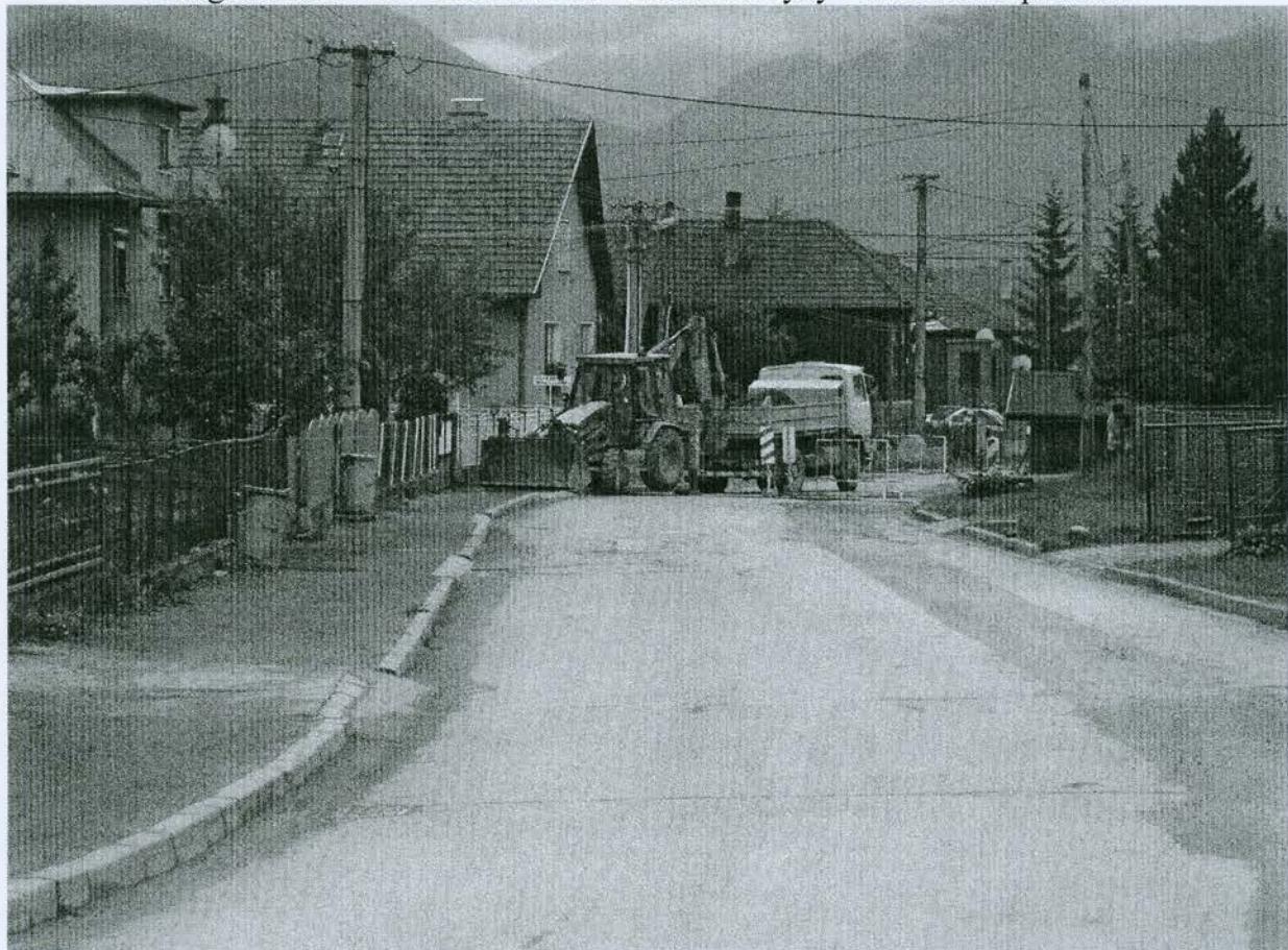
Fotografia č. 2 – SO Beňadiková – Dokončovacie práce
