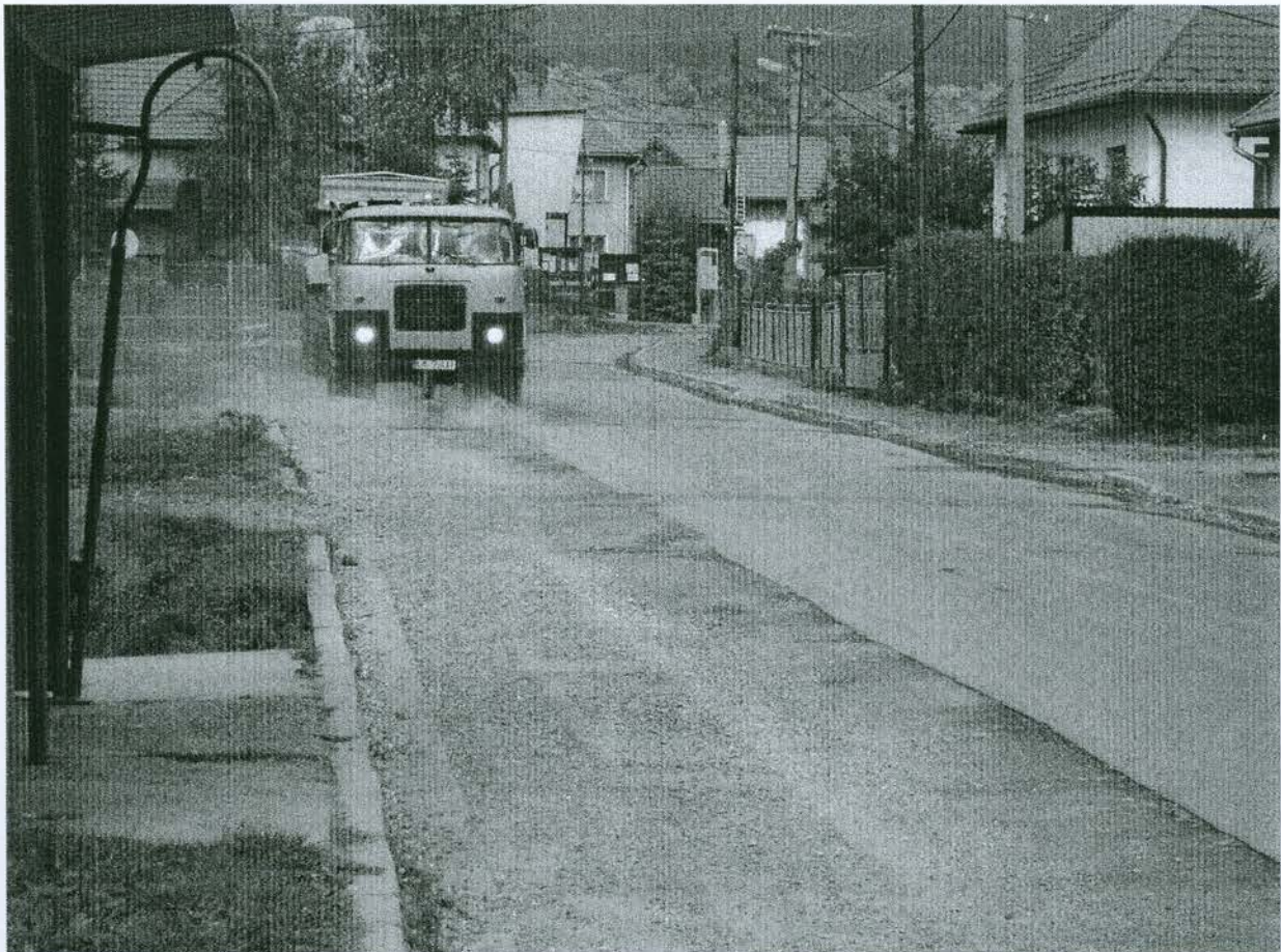
Fotografia č. 1 – SO Beňadiková – Striekacie ryhy – zabránenie prašnosti
