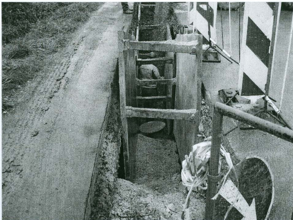
Fotografia č. 1 – SO Beňadiková – Výkop kanalizácie
