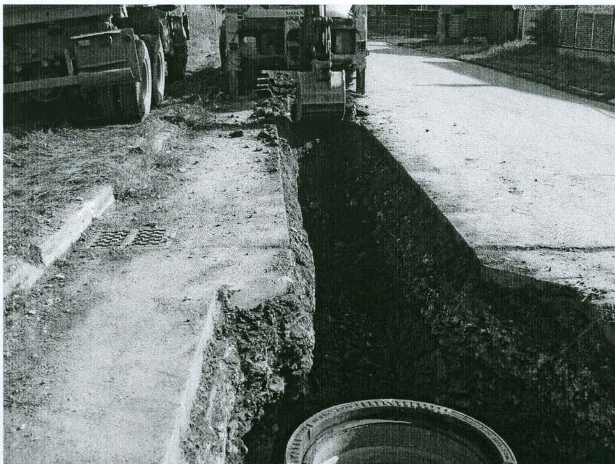
Fotografia č. 3 – SO Beňadiková – Odstraňovanie asfaltu hrúbky 60 cm
