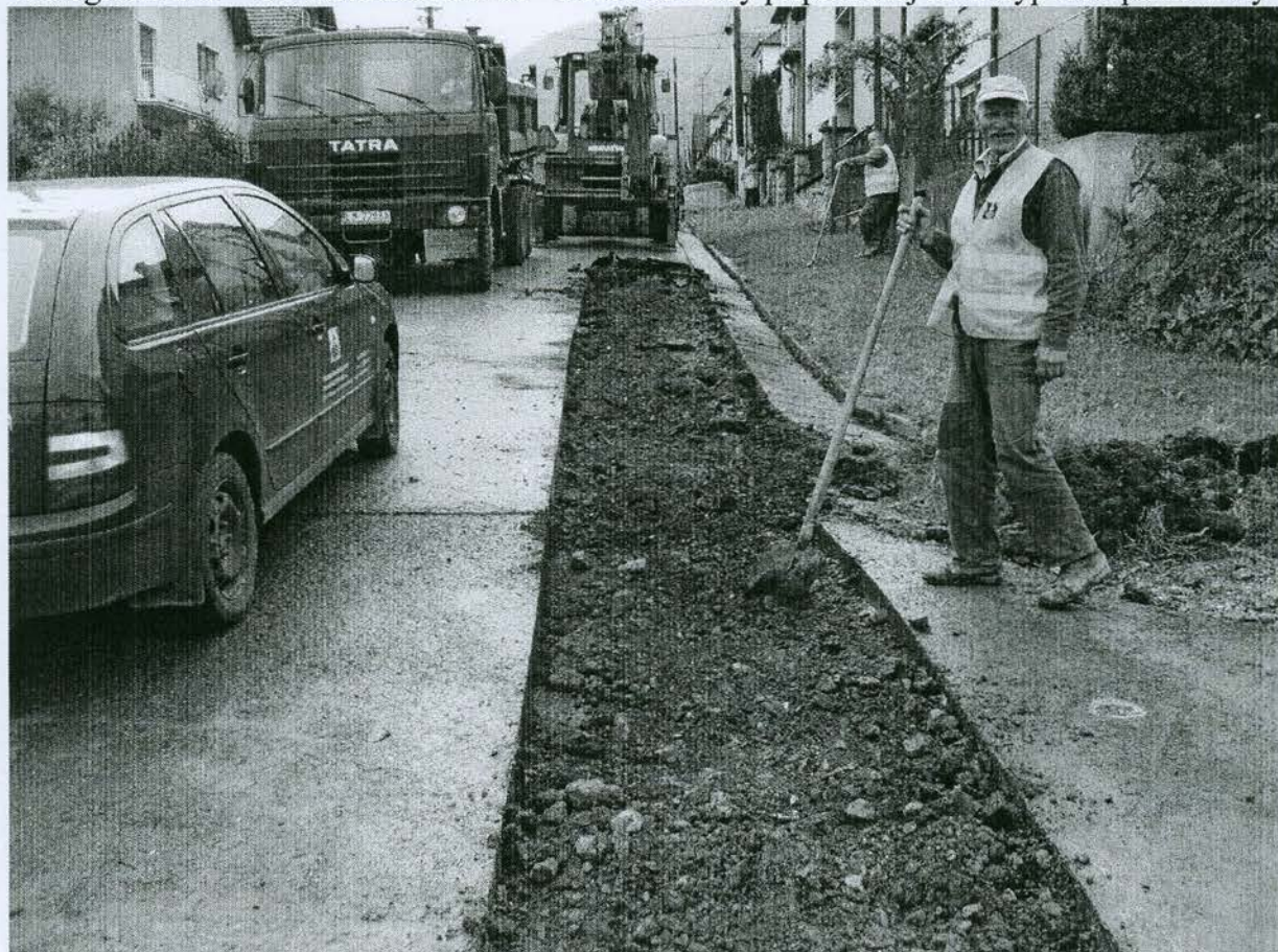
Fotografia č. 6 – SO Závažná Poruba – Odstraňovanie asfaltovej vrstvy
