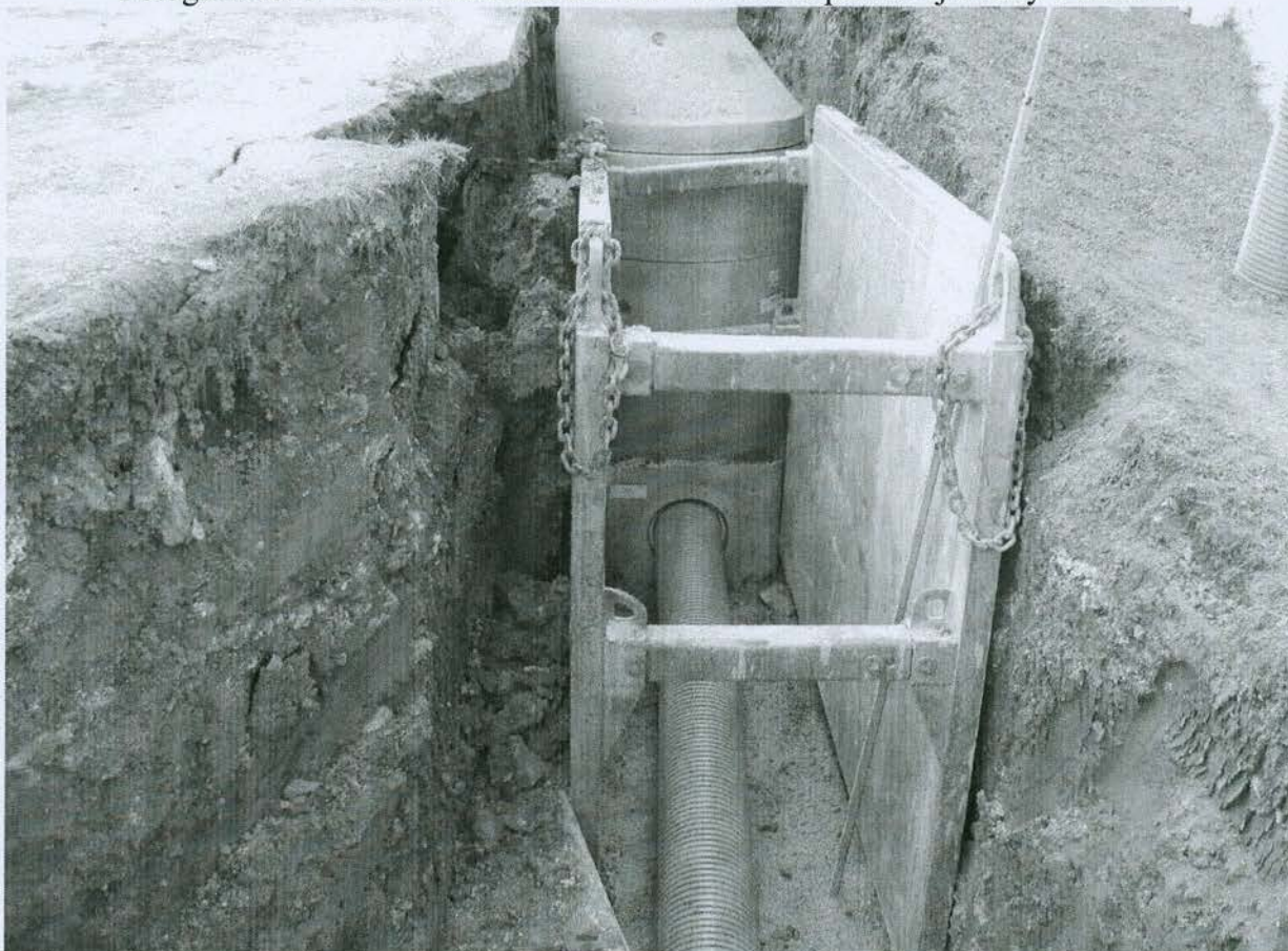
Fotografia č. 6 – SO L. Závažná Poruba – osadenie plastovej rúry DN 300 do šachtového dna
