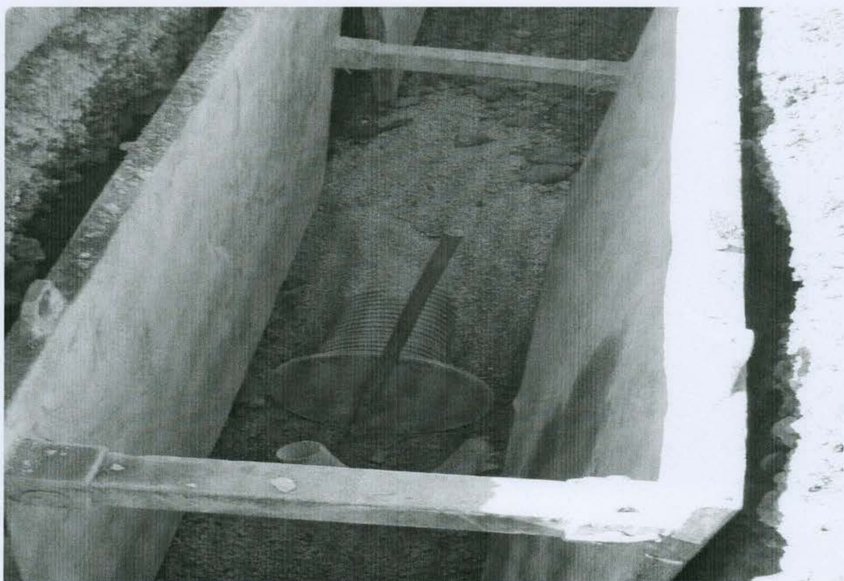
Fotografia č. 2 – SO Beňadiková – Obsyp a zásyp
