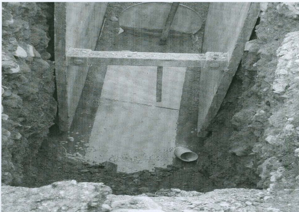
Fotografia č. 1 – SO Beňadiková – Kladenie drenážnej vrstvy a drenážnej trubky
