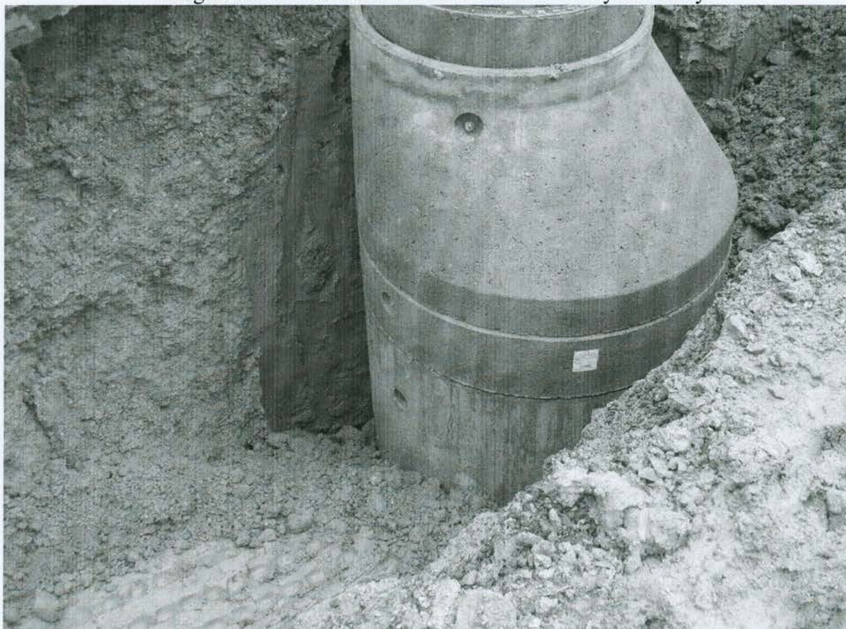
Fotografia č. 4 – SO L. Mikuláš Stošice – Vyskladaná kanalizačná šachta DN 1000
