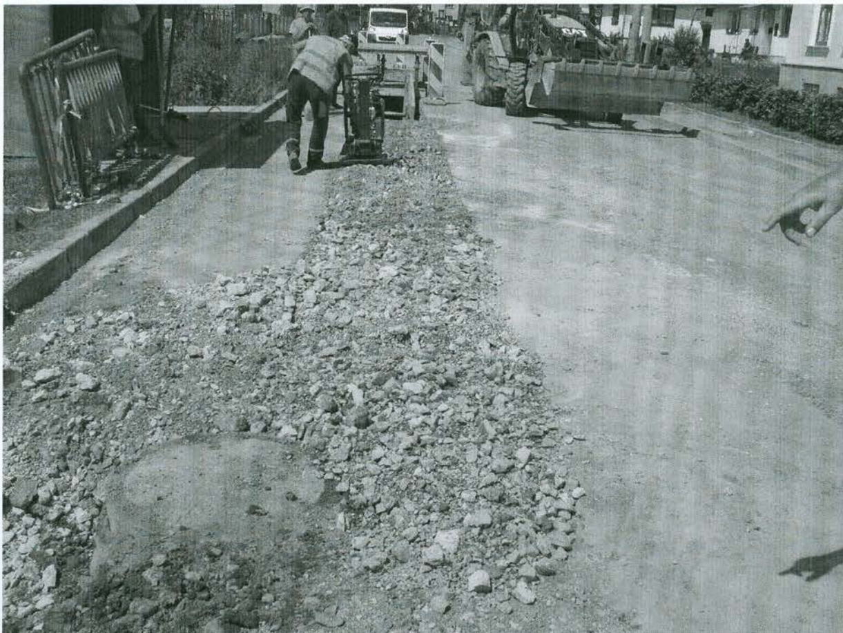
Fotografia č. 3 – SO Beňadiková – Hutnenie vrstvy štrkodrvy
