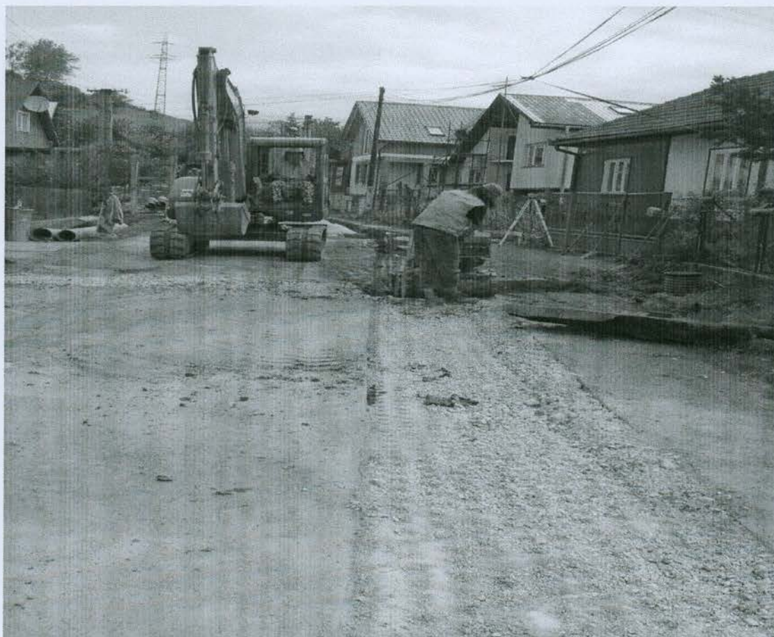
Fotografia č. 4 –SO L. Mikuláš Stošice – hutnenie rýh
