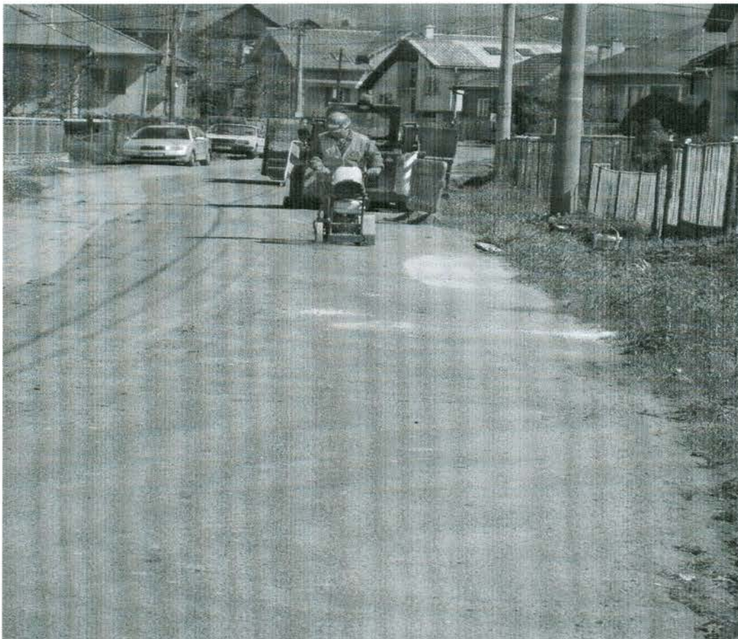
Fotografia č. 1 – SO L. Mikuláš Stošice – rezanie krytu z asfaltu
