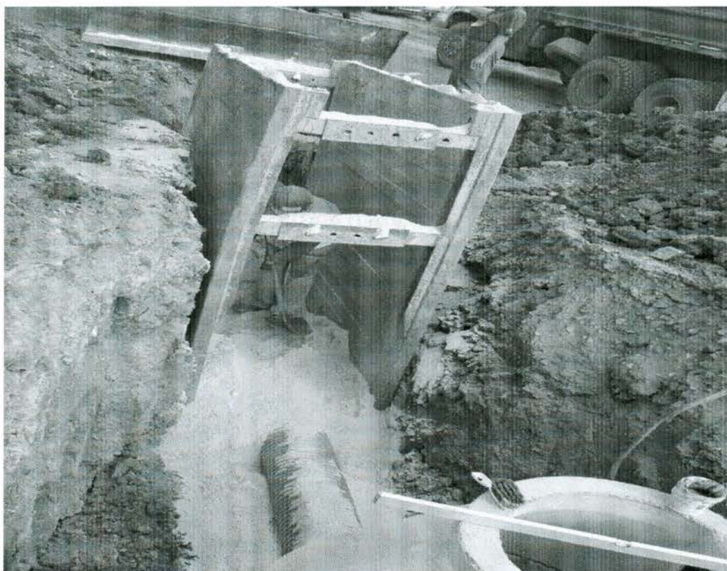
Fotografia č. 2 –SO L. Mikuláš Stošice – postupný zásyp frakciou 0/8 DN 300
