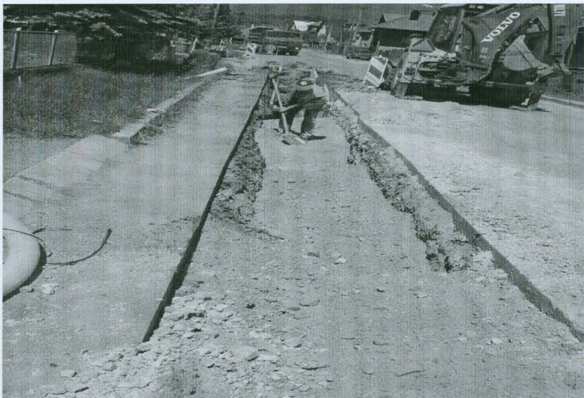
Fotografia č. 7 – SO Závažná Poruba – zásyp rýh
