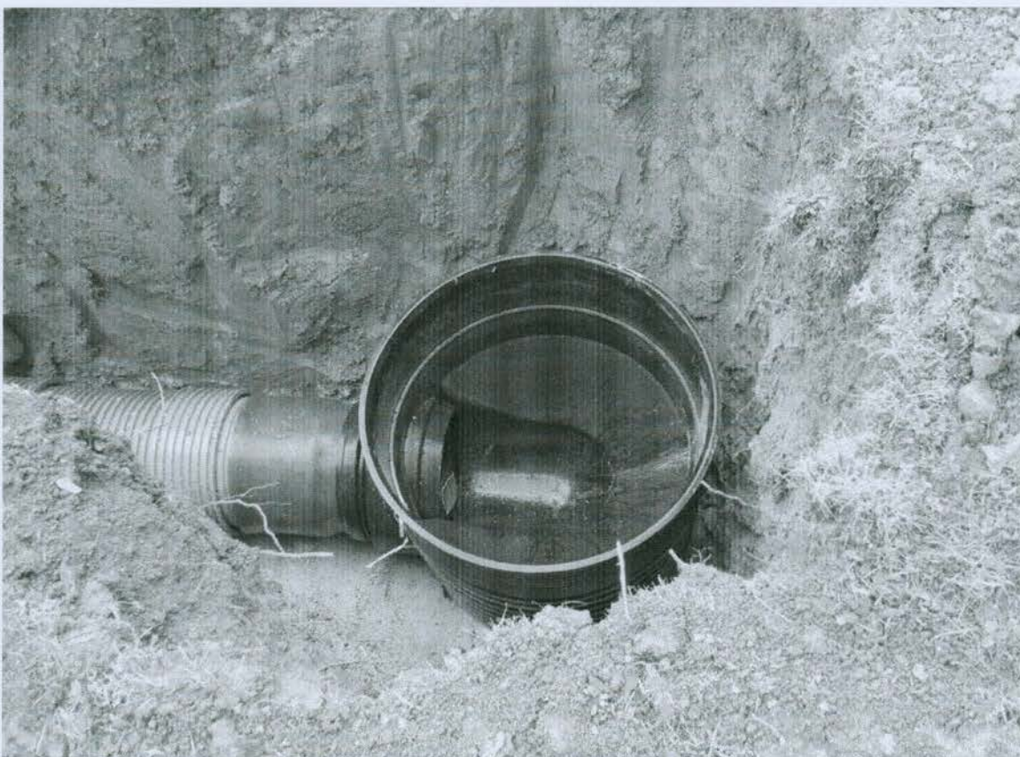
Fotografia č. 8 – SO Závažná Poruba – založenie plastovej šachty
