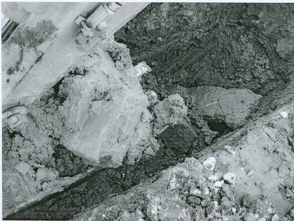
Fotografia č. 3 – hĺbenie rýh
