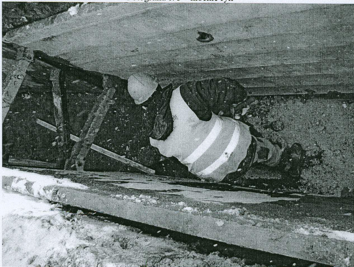
Fotografia č. 4 – príprava pieskové lôžko
