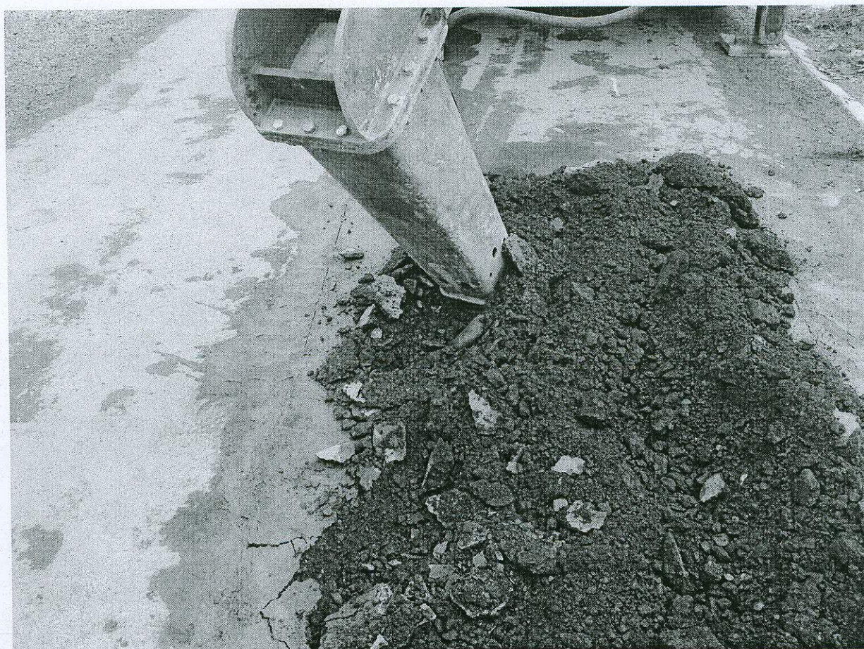
Fotografia č. 1 – Začatie prác – odstránenie podkladu vozovky
